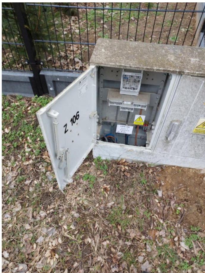
Złącze nr Z-106 typu ZK-1/R/P-1
